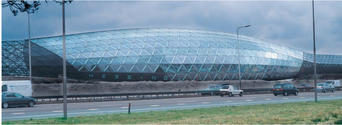
Zicht vanop de snelweg
